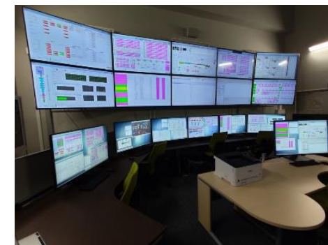
LIPAC遠隔実験制御室
