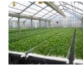
農業生産施設 (水耕栽培ハウス)
