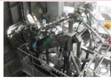
電子サイクロトロン加熱導波管
