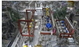
冷媒系安全弁ユニット
