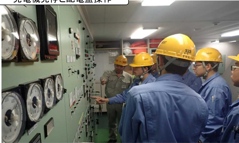
発電機発停と配電盤操作
