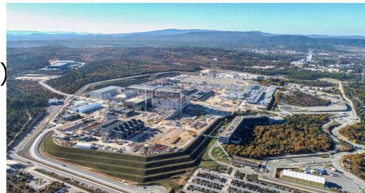
（令和2年11月時点・ITERサイト）
