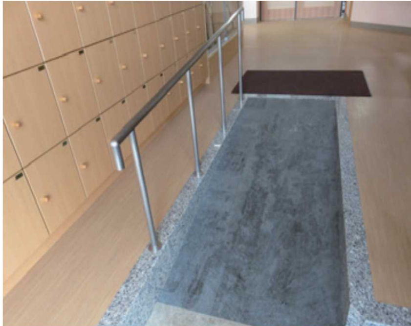
昇降口へのスロープ設置
