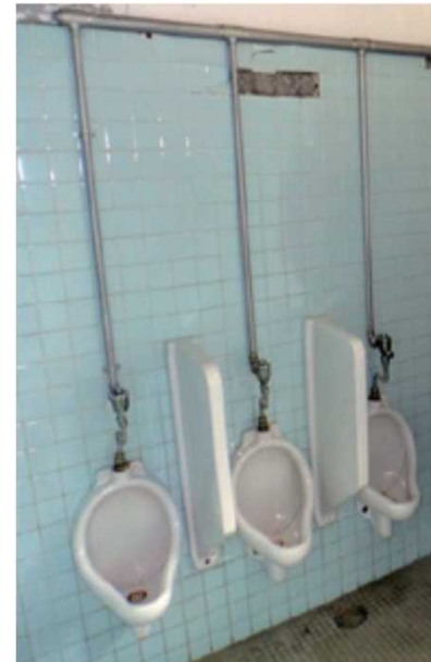
床を湿式から乾式に改修
