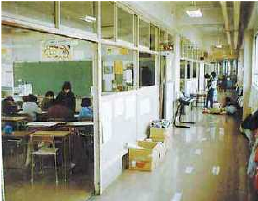
廊下と壁がある普通教室（改修前）
