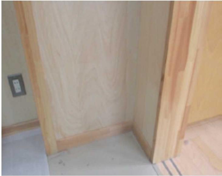
（施工後）欠損箇所補修・木仕上げ
