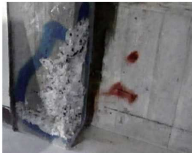
（施工前）柱や梁等に部分的なコンクリートの欠損
