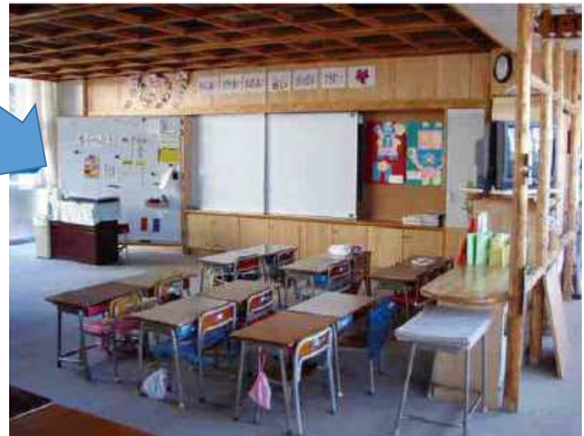
廊下との間仕切りを撤去（改修後）
