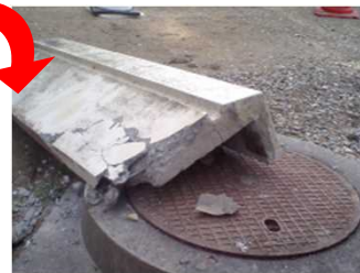
老朽化により手すりが落下
