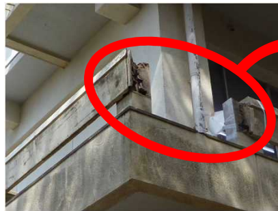
老朽化により手すりが落下
