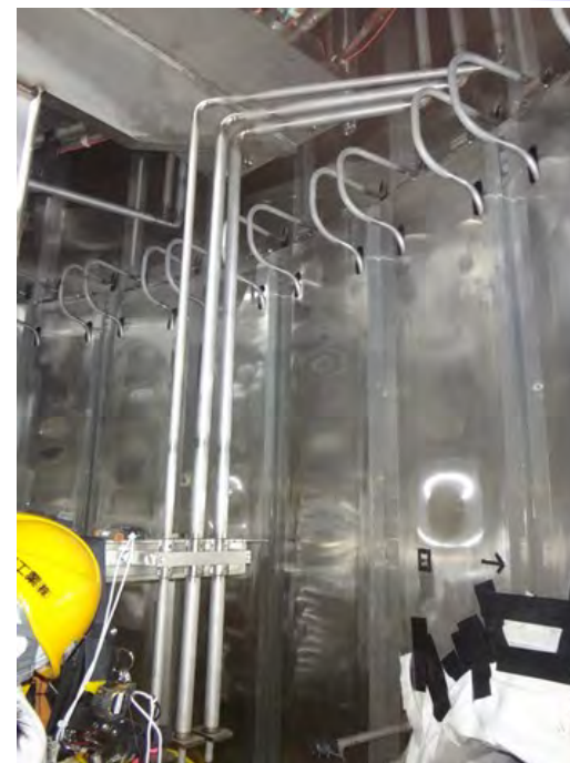
超伝導コイルEF6用冷媒配管
