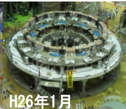
下側平衡磁場コイル
