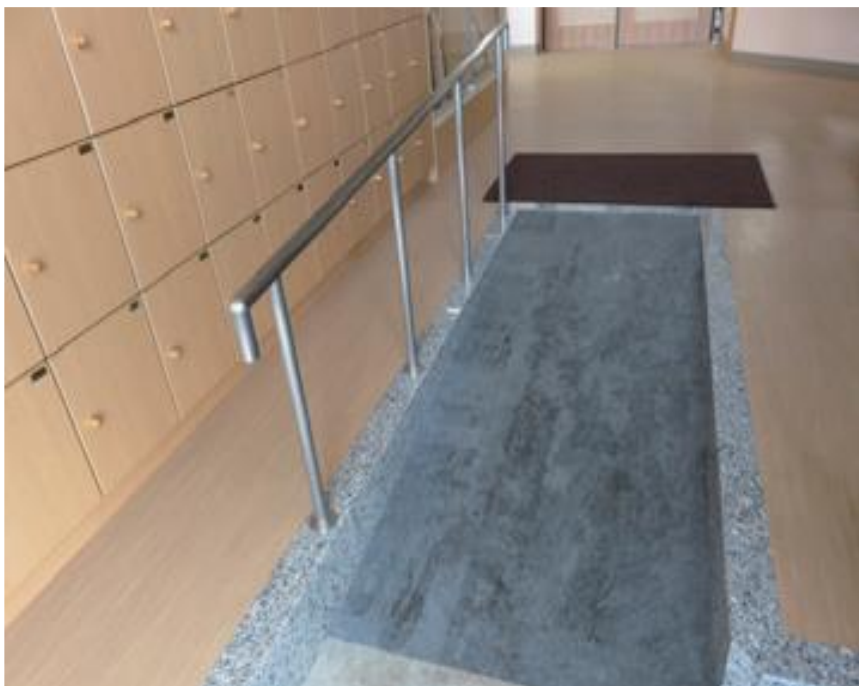
昇降口へのスロープ設置
