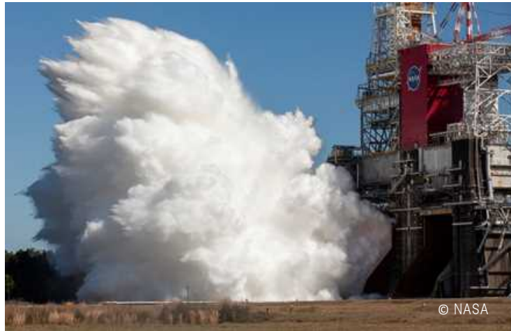
Green Run Test最終試験の様子
