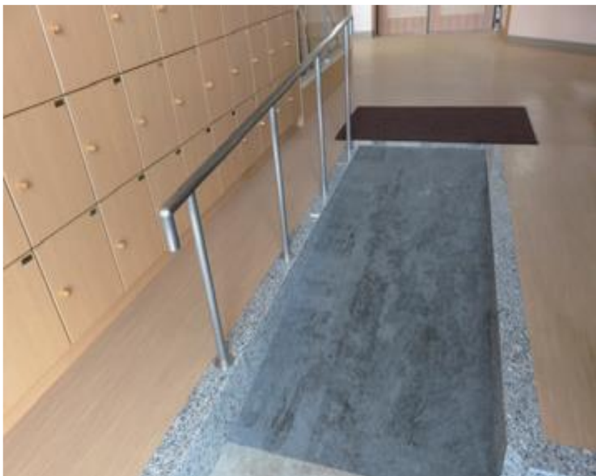
昇降口へのスロープ設置
