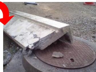
老朽化により手すりが落下
