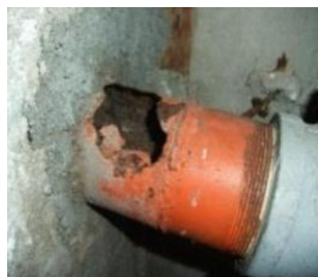
劣化による配管破損
