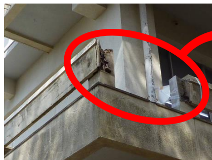
老朽化により手すりが落下
