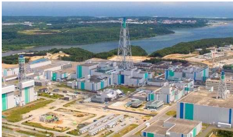
日本原燃 六ヶ所再処理工場(日本原燃HPより)
