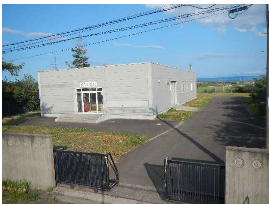
【試験研究棟建屋】
