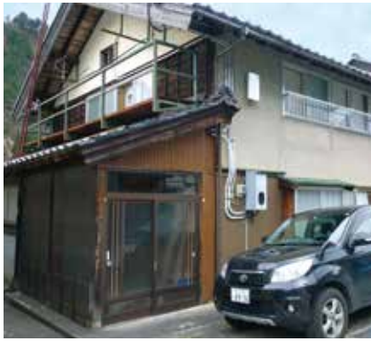
北陸サテライトは築百年の古民家を改修。 1階は32畳分のフローリングだ
