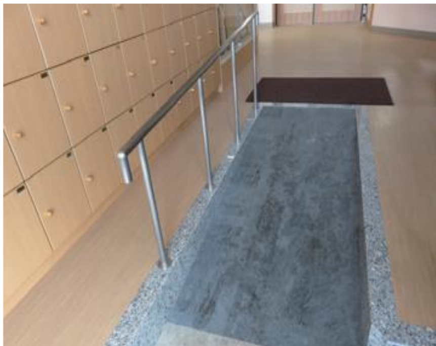
昇降口へのスロープ設置
