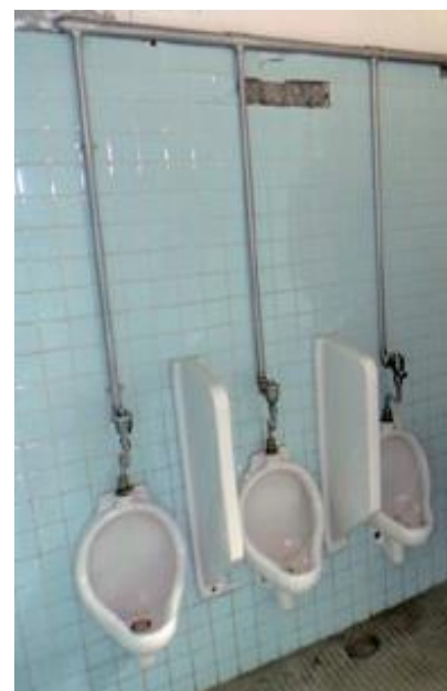
床を湿式から乾式に改修
