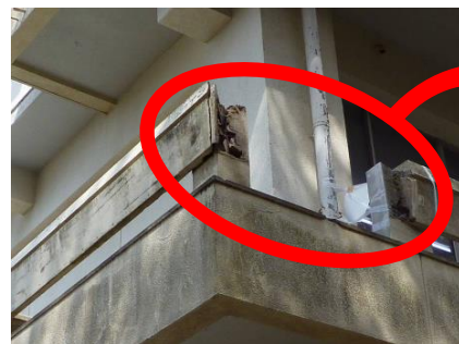
老朽化により手すりが落下
