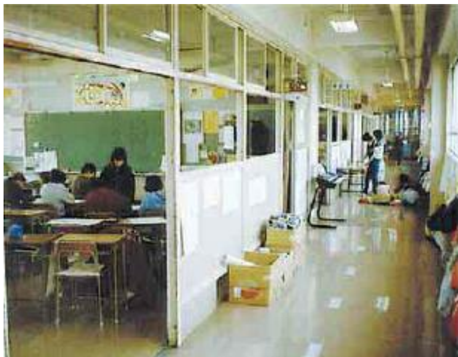
廊下と壁がある普通教室（改修前）
