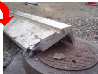
老朽化により手すりが落下
