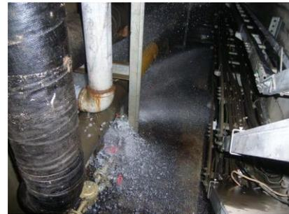
配管の破損による水漏れ
