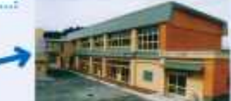
写真10b-2 改修後の校舎（改修後）
