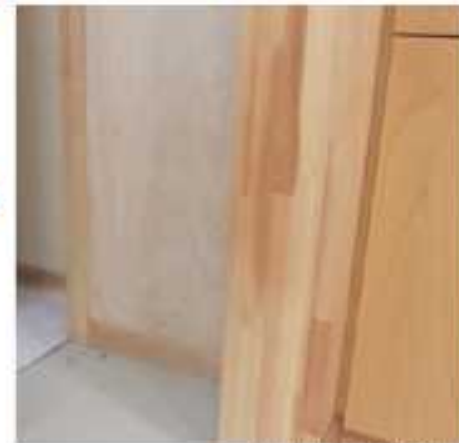
補修完了後に木仕上げを実施
