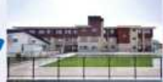
写真10a-2 改修後の校舎（改修後）
