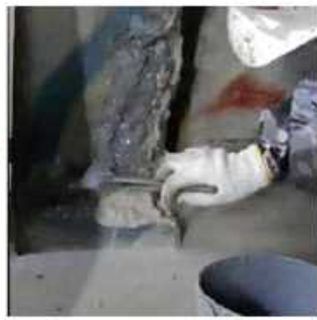
モルタルの付着を良くするための下地処理を塗布
