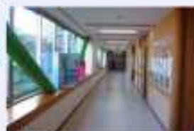
写真1b-1 耐震改修後の生活環境（右）
