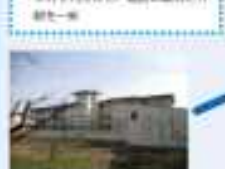
写真10a-1 改修前の校舎（改修前）
