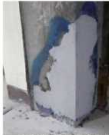
ほつりとした部分に無収縮モルタルを塗付
