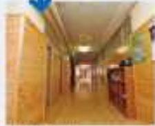
写真 5a-4 改修後の廊下（改修後）
