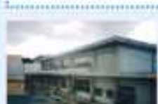
写真10b-1 改修前の校舎（改修前）
