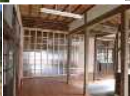
階段室の防寒間仕切り
