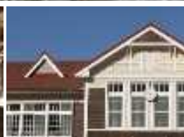
復活した小屋裏換気口
