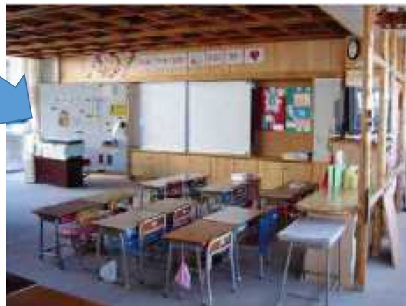
廊下との間仕切りを撤去（改修後）
