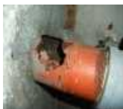
劣化による配管破損
