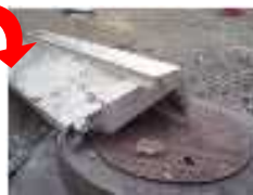
老朽化により手すりが落下
