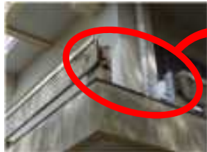
老朽化により手すりが落下
