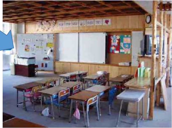
廊下との間仕切りを撤去（改修後）
