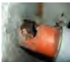
劣化による配管破損
