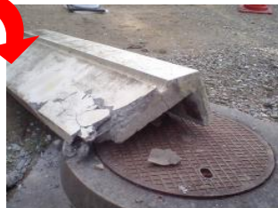
老朽化により手すりが落下
