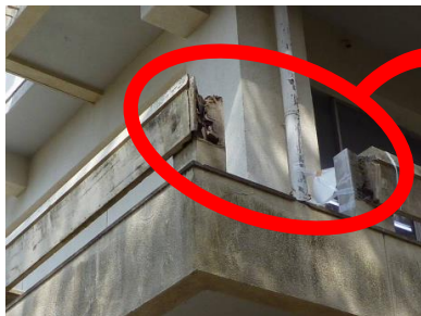
老朽化により手すりが落下
