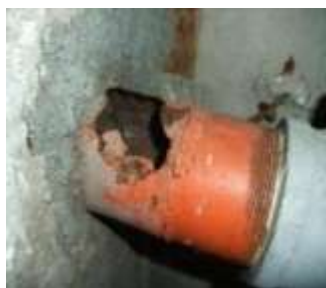
劣化による配管破損
