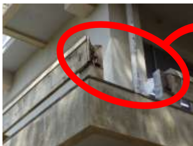
老朽化により手すりが落下
