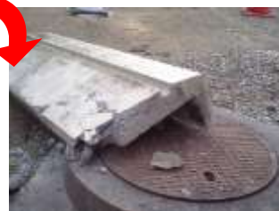
老朽化により手すりが落下
