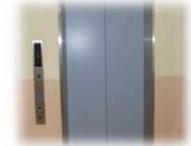
円滑な移動のためのエレベータの設置
