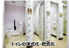
トイレの洋式化・乾式化
