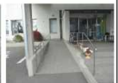
出入口の段差解消 事業費: 30万円程度
