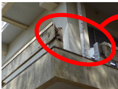
老朽化により手すりが落下
