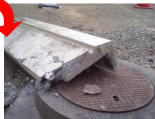
老朽化により手すりが落下
