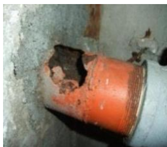
劣化による配管破損
