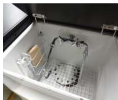
▲実験室のテーブル下の水道
