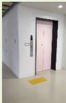
エレベーター
