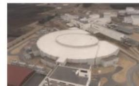
1990年 太陽熱による建物のひずみがビーム軌道の安定性に悪影響を及ぼすことがわかり、光源棟屋根の断熱化を行った。このことは、これ以降に建設された世界の放射光施設の設計に大きな影響を与えた。
