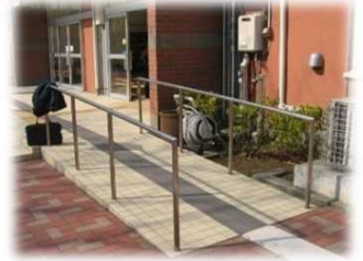
昇降口の段差解消のためのスロープの設置
