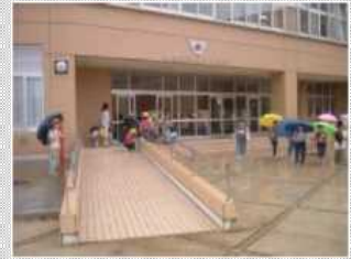
昇降口の段差をスロープにより解消した事例 (秋田県秋田市立 勝平小学校)
