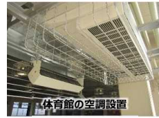
体育館の空調設置
