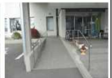
出入口の段差解消 事業費: 30万円程度
