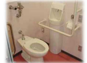
衛生的な多目的トイレの設置
