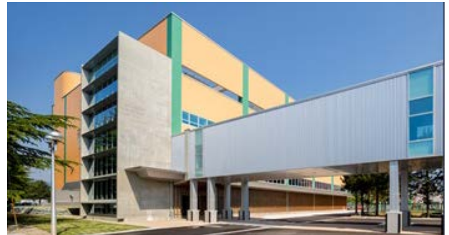
《東日本重粒子センター外観》
