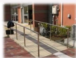
昇降口の段差解消のための スロープの設置
