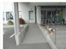
出入口の段差解消 事業費：30万円程度
