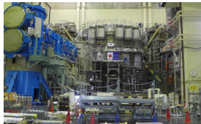
組立が完了したJT-60SA
