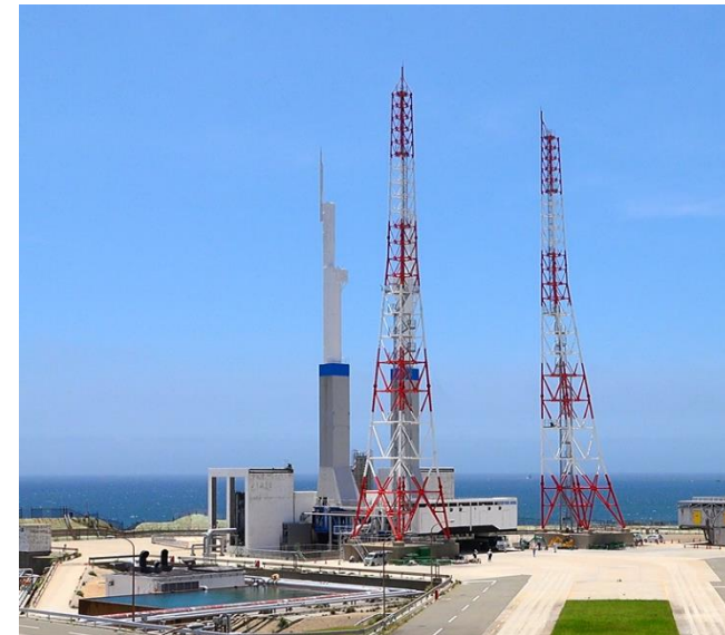
移動発射台(ML5)と第2射点(LP2)の結合状況
