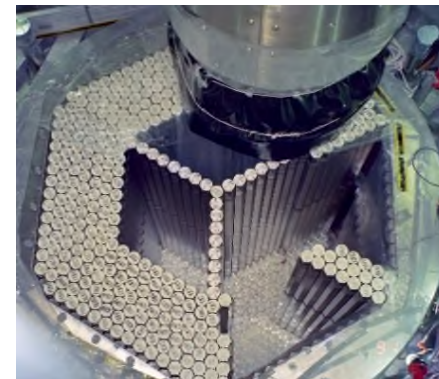
模擬燃料を装荷中の炉心（1991年） （炉心支持板連結管に差し込まれて自立）
