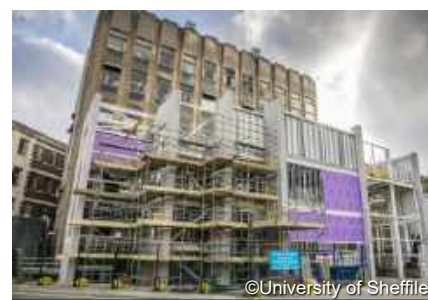
建設現場 2019 年 11 月
