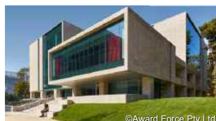
改修・増築後
