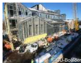
建設現場の様子 2019 年 12 月
