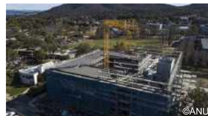
建設現場の様子, 2019 年 6 月
