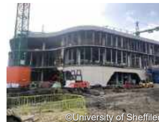
建設現場 2019 年 11 月
