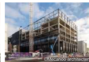
建設現場 2019 年 5 月
