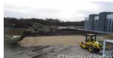
建設現場 2020 年 2 月
