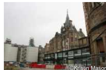
拡張工事の様子
