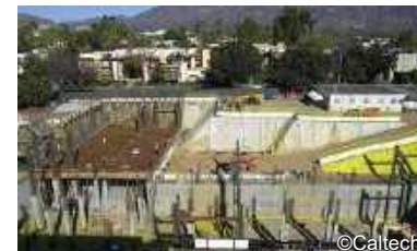
建設現場の様子，2019 年 1 月
