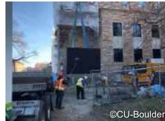
建設現場の様子 2019 年 12 月
