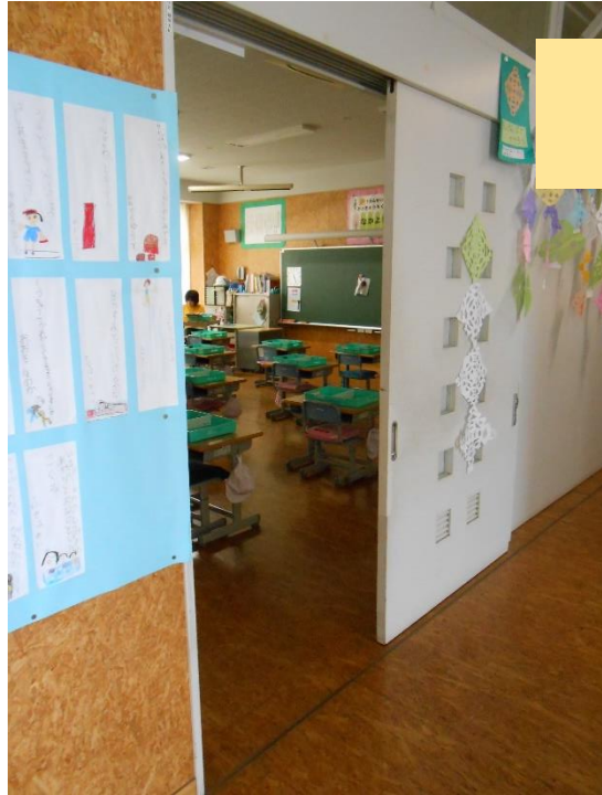
教室出入口 吊し扉で、床面には レール(段差)なし
