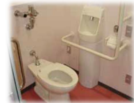
衛生的な多目的トイレの設置
