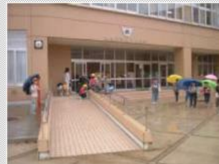
昇降口の段差をスロープにより解消した事例 (秋田県秋田市立 勝平小学校)
