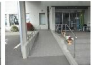
出入口の段差解消 事業費：30万円程度
