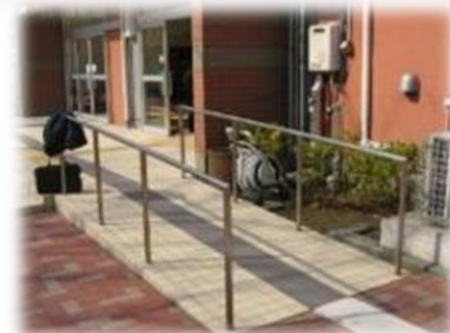
昇降口の段差解消のための スロープの設置
