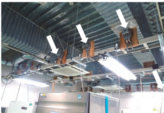
フリーザー室に設置された電力量計
