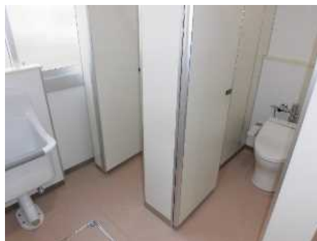
衛生を保ちやすい乾式・洋式トイレに改修
