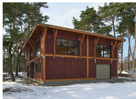
写真4 CLTパネル工法の建築 (新潟県少年自然の家)
