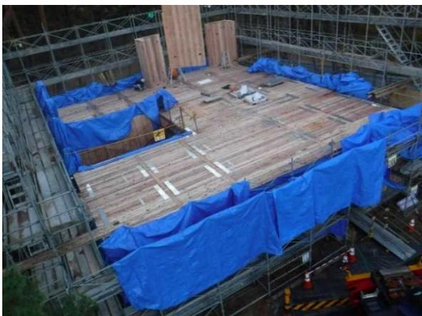
写真7 野外棟の建設現場(CLT 2階壁施工)
