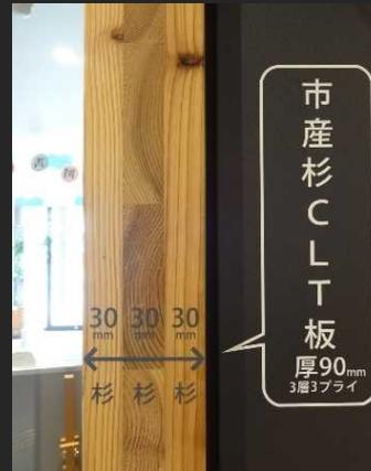
写真9 内装断面に記載された市産杉CLTのサイン
