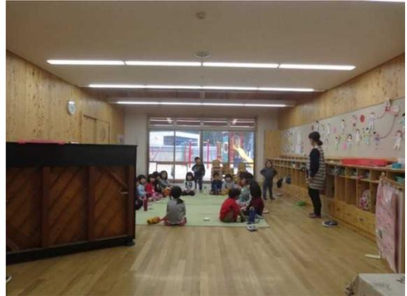
写真2 CLTパネル工法を用いた、CLT現しの保育室
