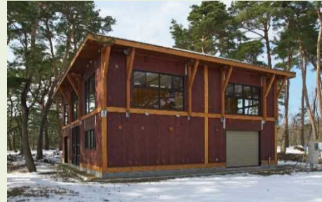
CLTパネル工法の建築（新潟県少年自然の家）
