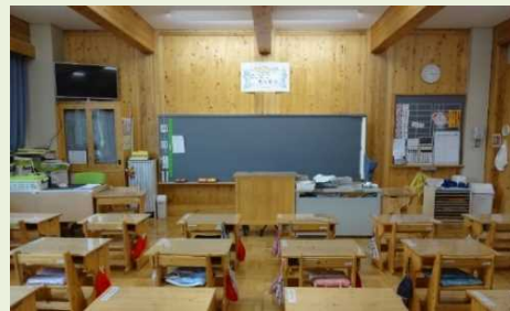
耐力壁にCLTを活用した普通教室（真庭市立北房小学校）
