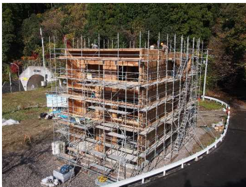
スピーディーな組立て（構造部分2日間） （おとよ製材 社員寮（高知県））
