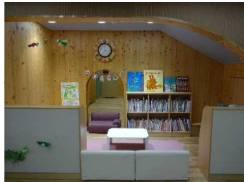
曲線にカットされたCLTの現し壁面 （真庭市立北房こども園）
