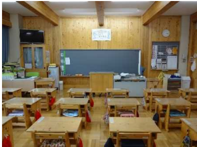
写真5 耐震壁をCLTの現しとした小学校普通教室の黒板側
