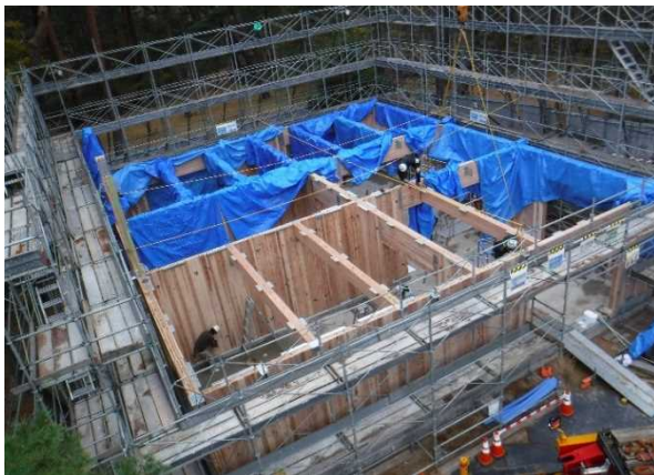
写真5 野外棟の建設現場(CLT 1階壁施工②)
