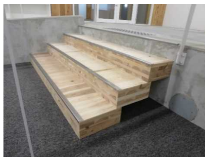
写真1 CLTの端材を活用した、側面が現しとなっている小階段
