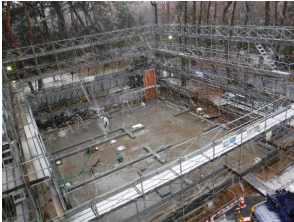
写真3 野外棟の建設現場(CLT施工開始)
