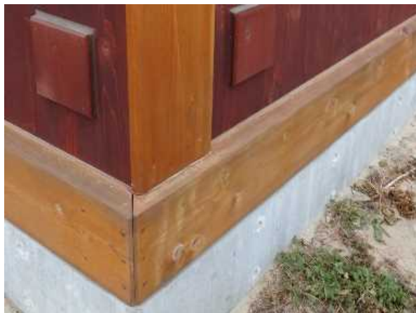
写真10 上下の接合金物をシール材をした蓋で隠す
