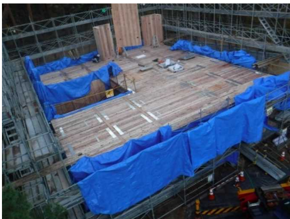
写真7 野外棟の建設現場(CLT 2階壁施工)
