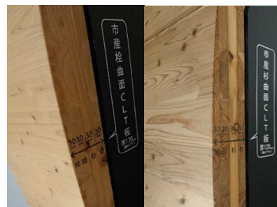
写真3 桧と杉との色ムラの比較（左が桧、右が杉） （真庭市立中央図書館）
