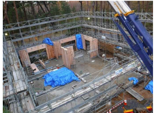
写真4 野外棟の建設現場(CLT 1階壁施工①)
