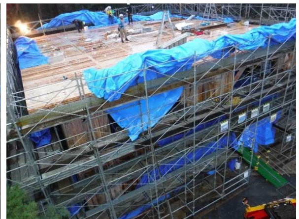
写真8 野外棟の建設現場(CLT屋根施工)
