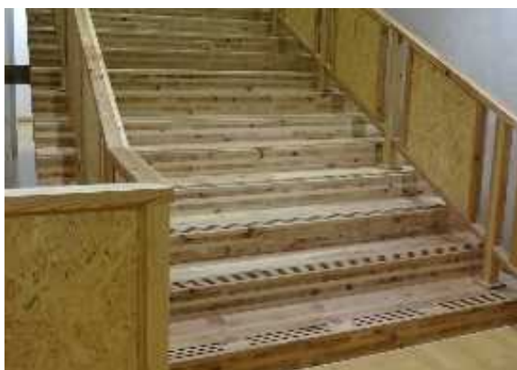
写真11 CLTの層部分が見える大階段
