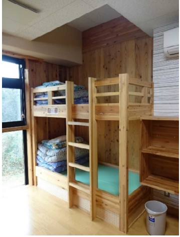
写真2 宿泊棟 宿泊室CLT耐震壁
