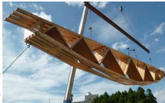
写真1 組立梁を吊り上げる様子
