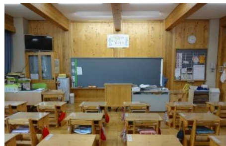
写真6 耐震壁にCLTを 現しで活用した普通教室 (真庭市立北房小学校)
