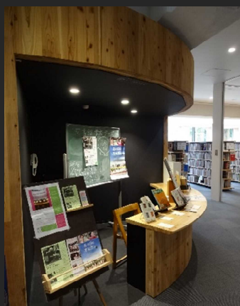
写真8 杉材CLTで出来た内装とカウンター
