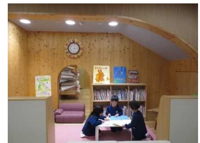
写真4 CLTの壁面を曲線カットしたこども園の図書コーナー
