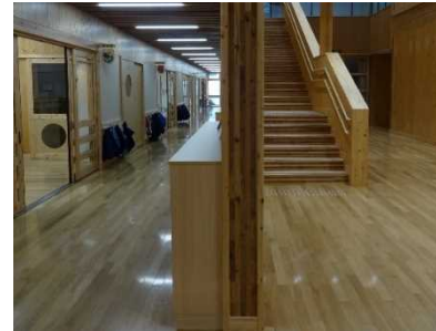
写真7 左の保育室エリアと右の遊戯室エリアを分ける7層のCLT
