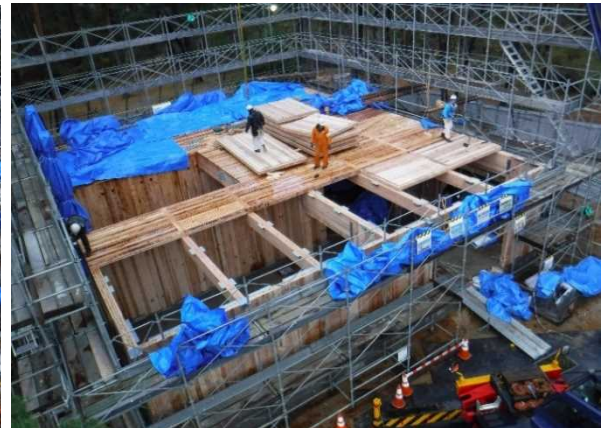
写真6 野外棟の建設現場(CLT 2階床施工)
