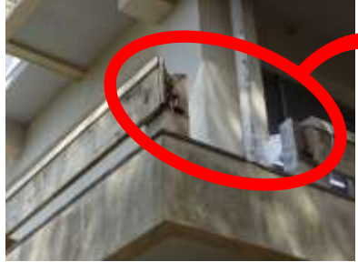
老朽化により手すりが落下
