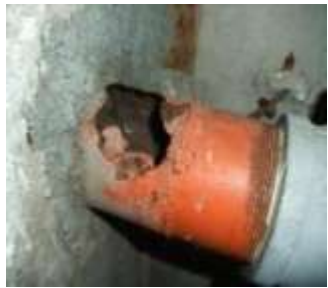
劣化による配管破損
