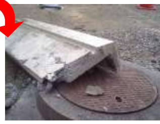
老朽化により手すりが落下
