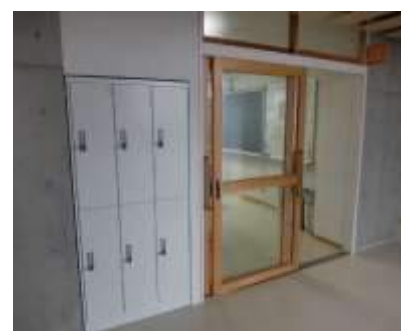
▲壁に埋め込まれたロッカー
