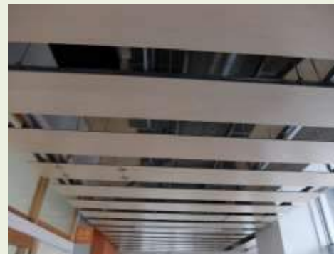
メンテナンスを考慮した廊下の天井
