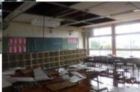
暴風により窓ガラスが破損し、雨風が吹き込み、天井や床に被害
