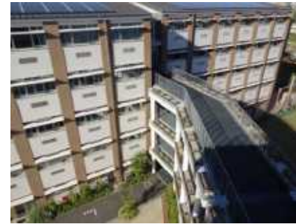
▲教室棟とアリーナ棟には避難やバリアフリーに配慮し渡り廊下を複数階に設置。
