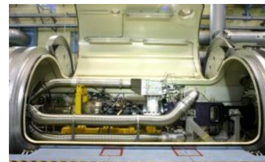
高空性能試験設備(ATF)
