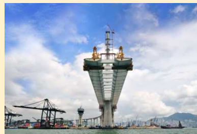
香港 ストーンカッターズ橋
