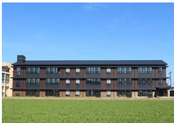
富山県 魚津市立星の杜小学校
