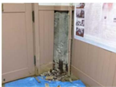
■長年の塩害等で爆裂した柱脚部
