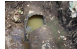
配管の腐食
